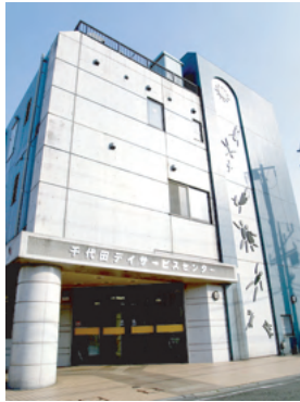
鉄筋コンクリート4階建て
